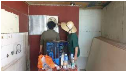
06.06. 빼빼로보관소 1차 리모델링 장영원, 최정원, 조광희, 김현주 공간에 필요한 자재 1차 구매 및 공간에 불필요한 것들 철거 및 정리
