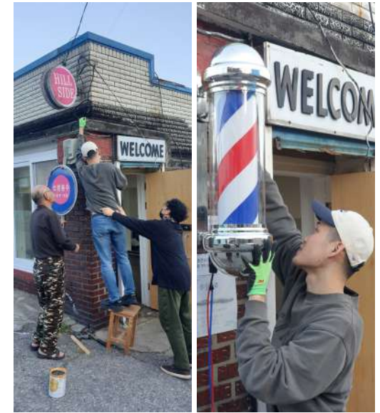
일시적 이발소-영호름 설치 과정_ Barber Pole 설치
