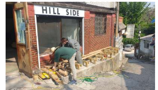
1차 리모델링 과정_ 장영원님과 최정원님의 외부 데크 제작 _ 2021.06.06.
